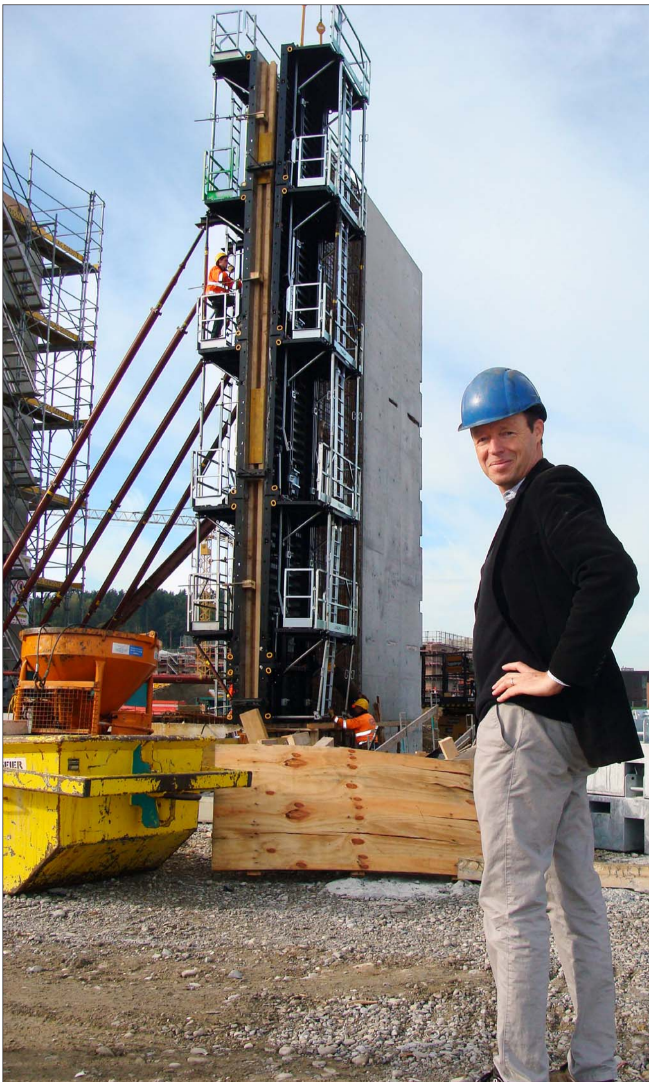
Mit Architekt Peter Schürch auf der Baustelle der Ostermundiger Überbauung «Wohnen im Oberfeld»: «Solararchitektur will die Kilowattstunde optimieren und für die Bewohner sinnvolle Räume schaffen.»
