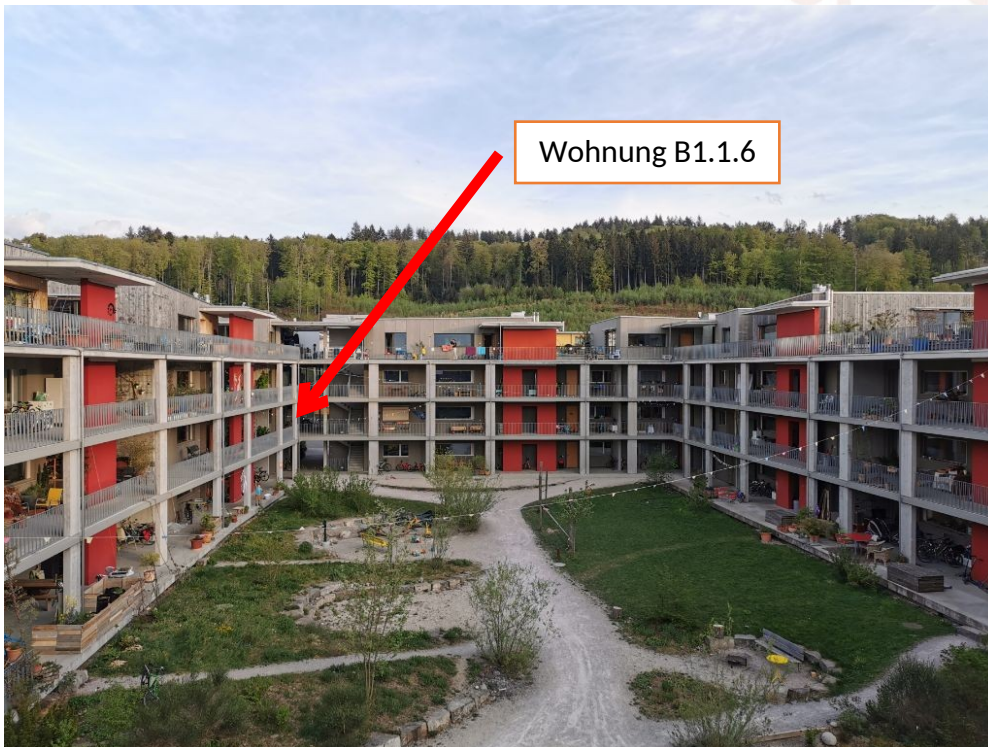
Innenhof der Siedlung Oberfeld
